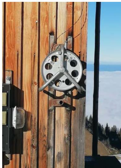
Beim Materialmagazin wurden die beiden Kabelverlängerung so montiert, dass diese im Frühling abgebaut und verräumt werden können. Damit besteht die Gefahr nicht mehr, dass diese Kabel durchgetrennt werden können.
